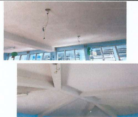
Foto 4: La mayoría de los salones de clase tienen dañada la instalación eléctrica o carecen de lámparas.
